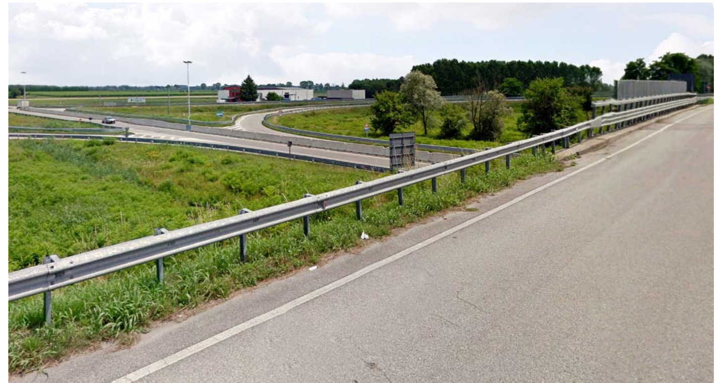
Svincolo tra la SS14 e la SR 354
