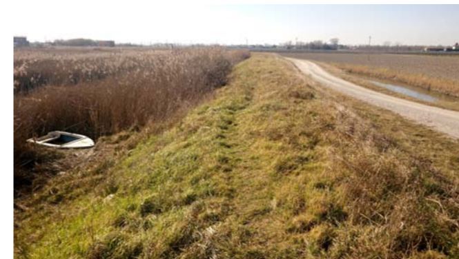
La gronda lagunare a Sud di Precenicco
